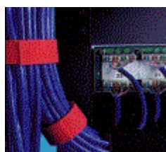
Figura 3 - Cabos unidos com velcro (correto)
