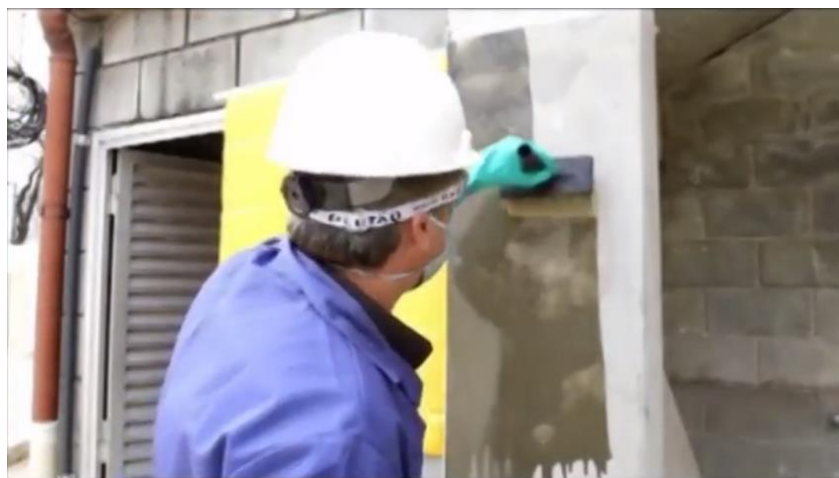
Figura 8- Aplicação de hidrofugante com trincha.
