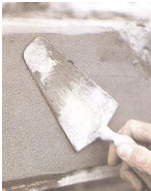
Figura 7- Acabamento da superfície reparada.
