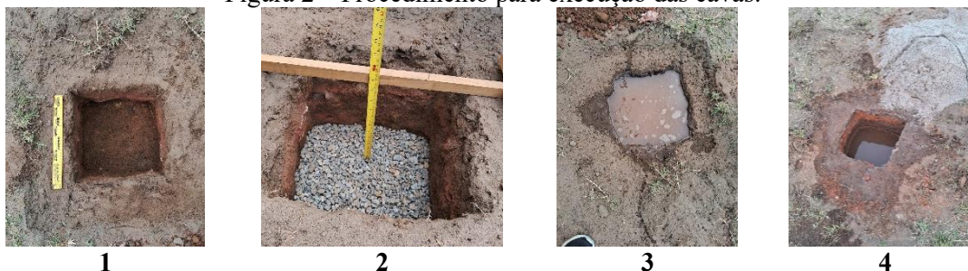
Figura 2 – Procedimento para execução das cavas.
