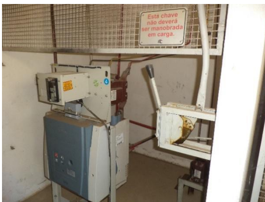
Foto 1 – Cella do disjuntor geral da Praia Vermelha sem anteparo
