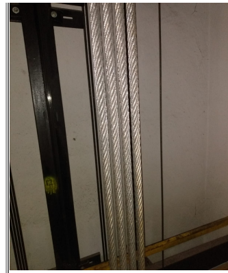
Foto 4 - Cabo de aço sem avaria após a ocorrência. Aatoria: Iago Ozaires
