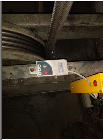
Foto 2 - Limitador de peso - marcador de peso. Aatoria: Iago Ozaires
