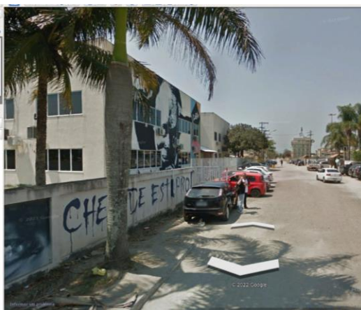
Prédio onde será instalado 01 Equipamento de transporte vertical (já possui caixa pronta)
