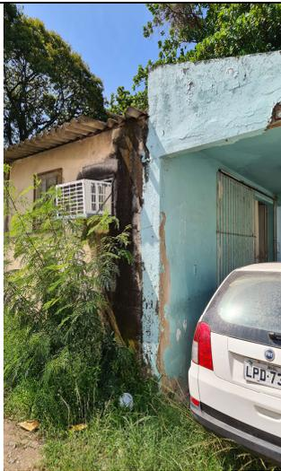
Figura 07: Infiltração/ telha quebrada.
