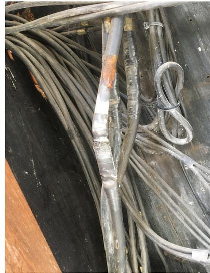
Figuras 2 e 3 - Emenda existente no cabo alimentador do QDG-A com sua temperatura de operação
