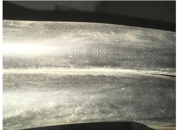
Foto 04 - Cabo alimentador QGBT's - 500,0 mm<sup>2</sup>
